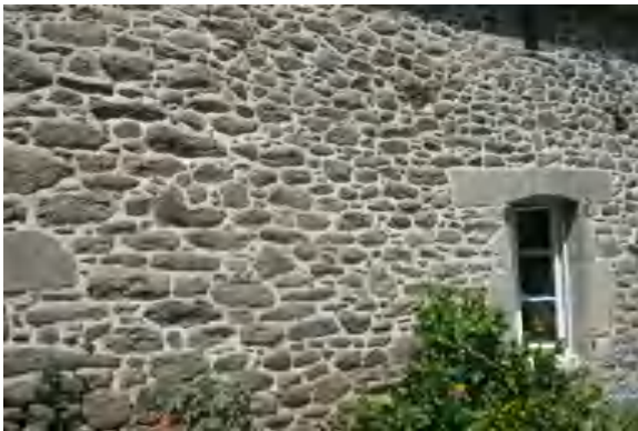
Exemple de joints extérieurs chaux/sable
