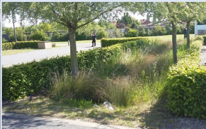
Figure 22 : Illustrations de noues d'infiltrations
