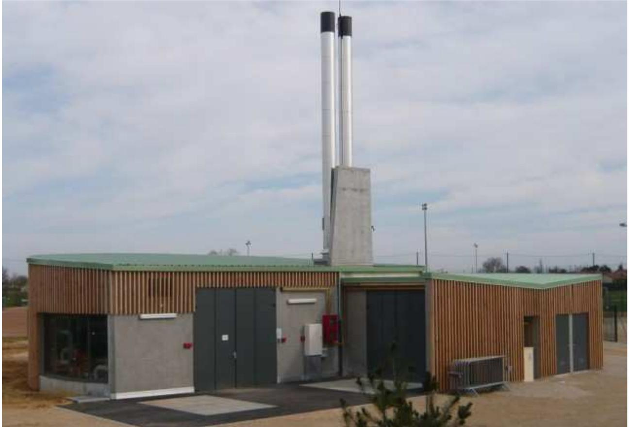
*Exemple de chaufferie bois à Saint Denis-lès-Bourg (01) de puissance 800 kW, de surface 200m<sup>2</sup> et consommant 600 tonnes de bois par an.*
