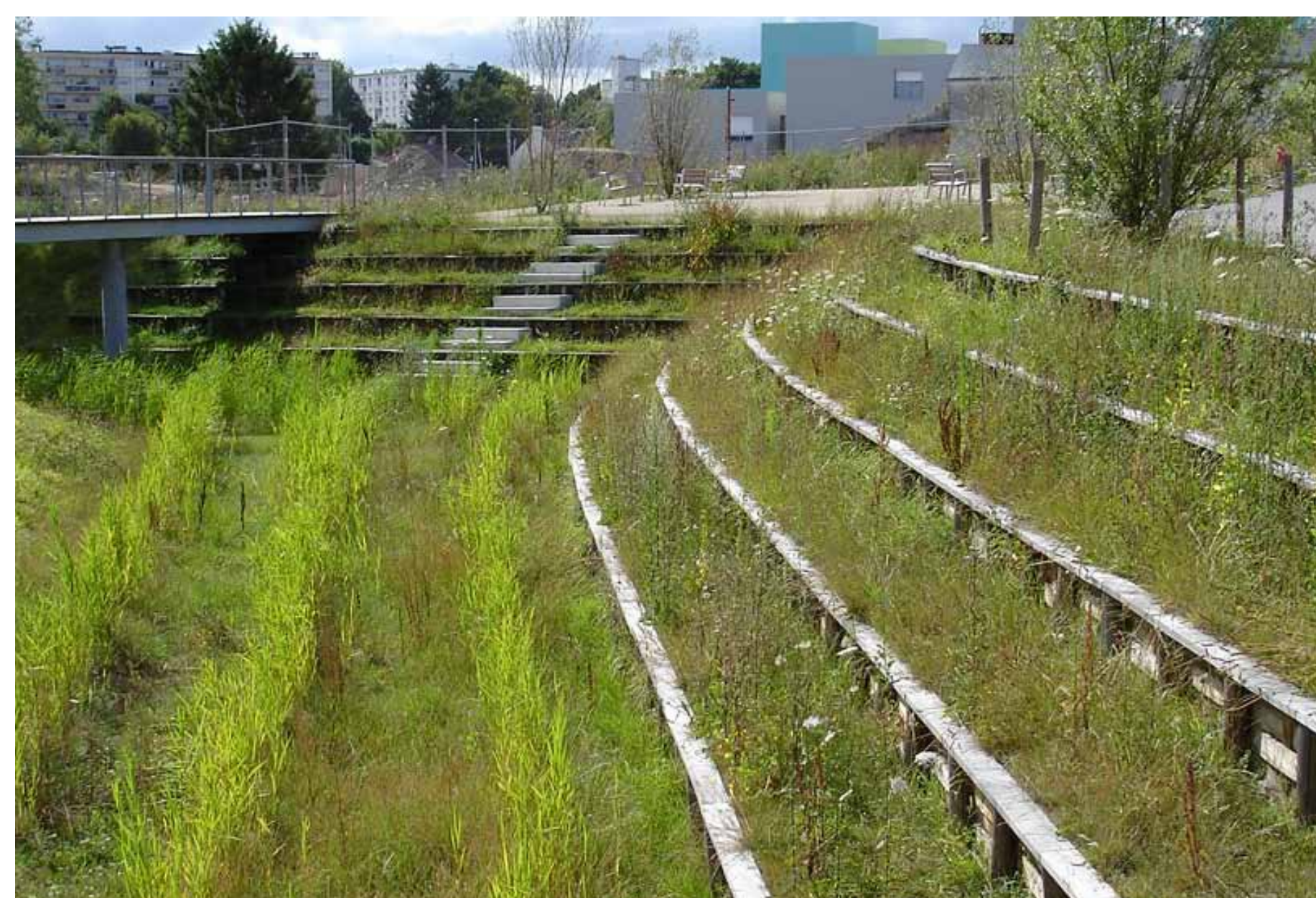
Pour une gestion aérienne des eaux pluviales : des noues, des bassins paysagers, des prairies humides comme support du parcours de l'eau
