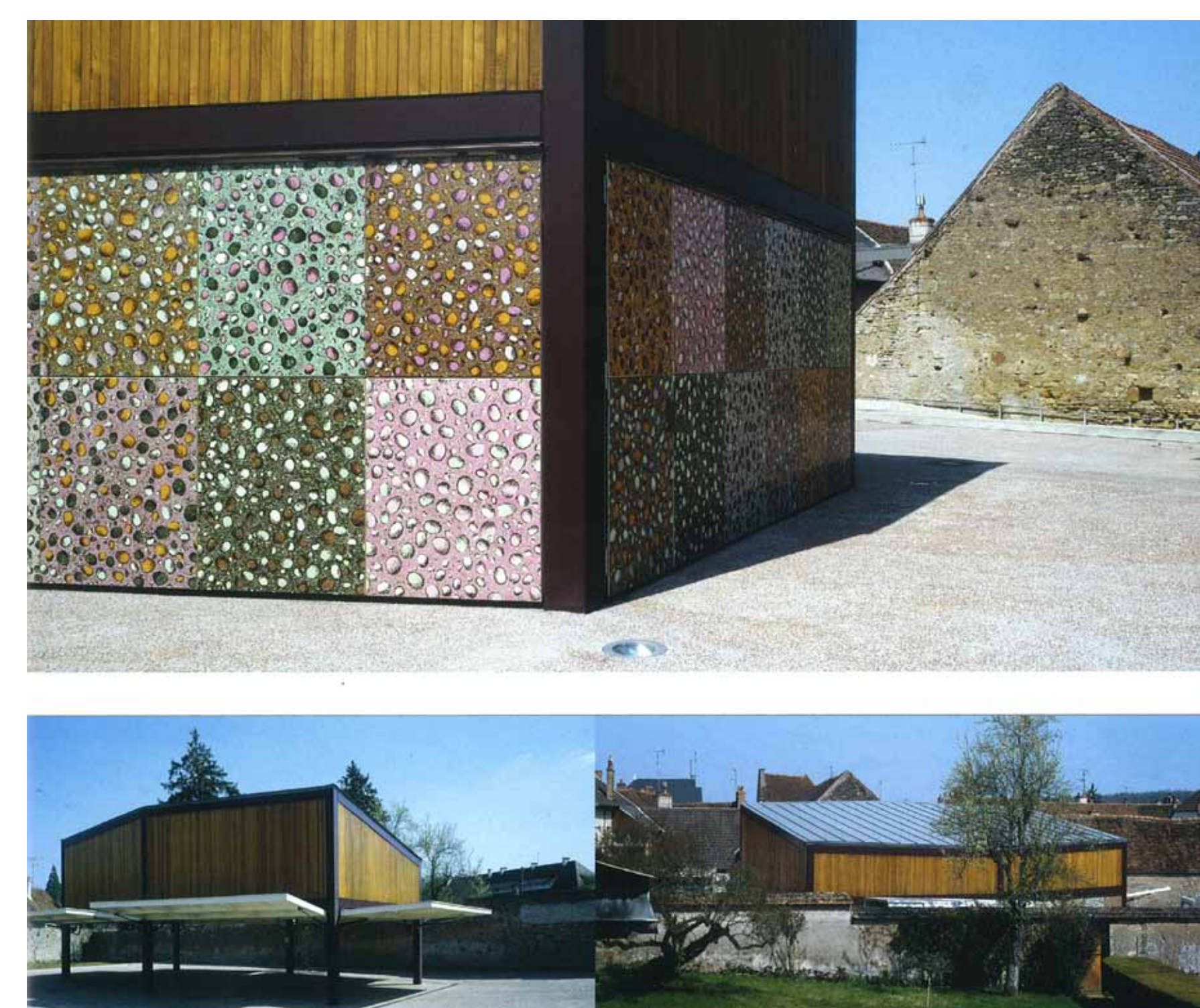
Halle (Louet / Lecq architecte : Arnay le Duc)
