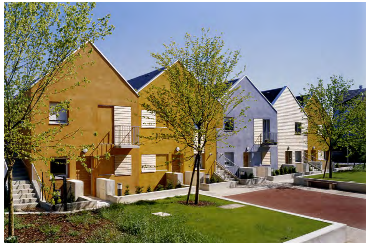
Logements intermédiaires à Saint Denis Atelier PO & Po 2
