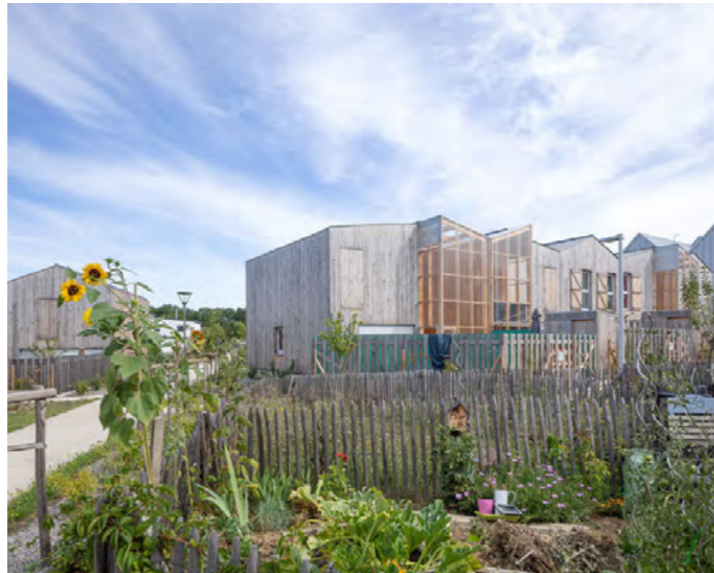
Logement à Thouaré 2 Berranger et Vincent Architectes © François Dantart
