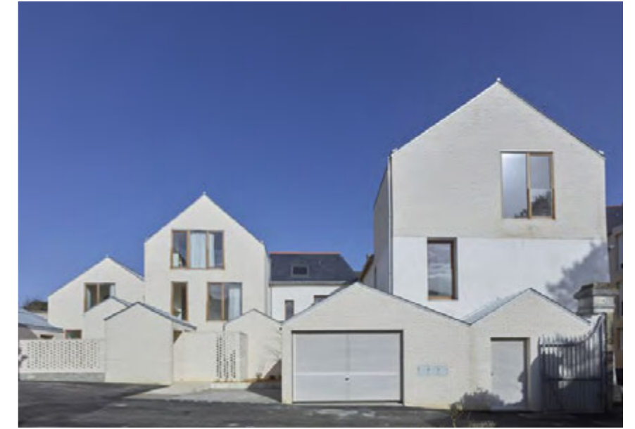
Logements à Mauves sur Loire Tact Archi © S. Chalmeau 2
