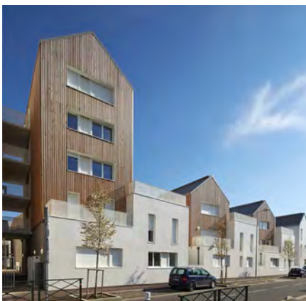
La mixité des toitures et matériaux permet une opération bien intégrée. Logements à Nanterre - Atelier Du Pont © F. Delangle
